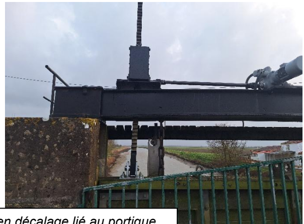
Génie civil dégradé et crémaillère en décalage lié au portique
