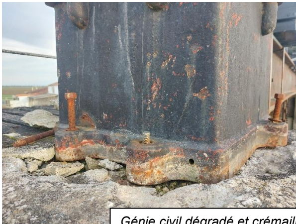
Génie civil dégradé et crémaillère en décalage lié au portique
