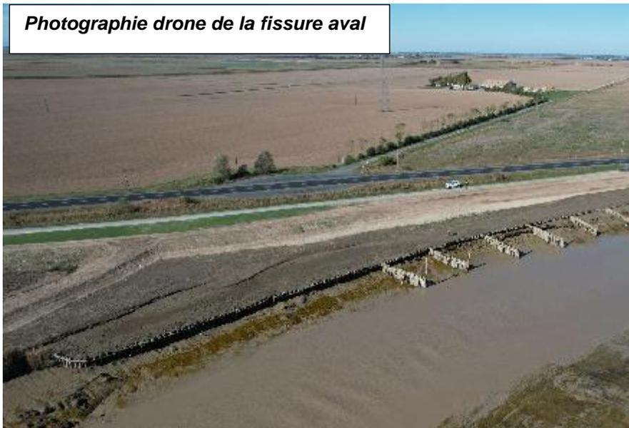
Cette fissure est apparue en premier à l'aval des travaux puis s'est étendue d'aval en amont sur environ 100 m, avec une ouverture de plus de 20 cm un décrochement (rejet) parfois supérieur à 40 cm.
